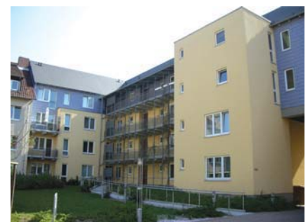
Abb.6 Untersuchtes MFH in Braunschweig
